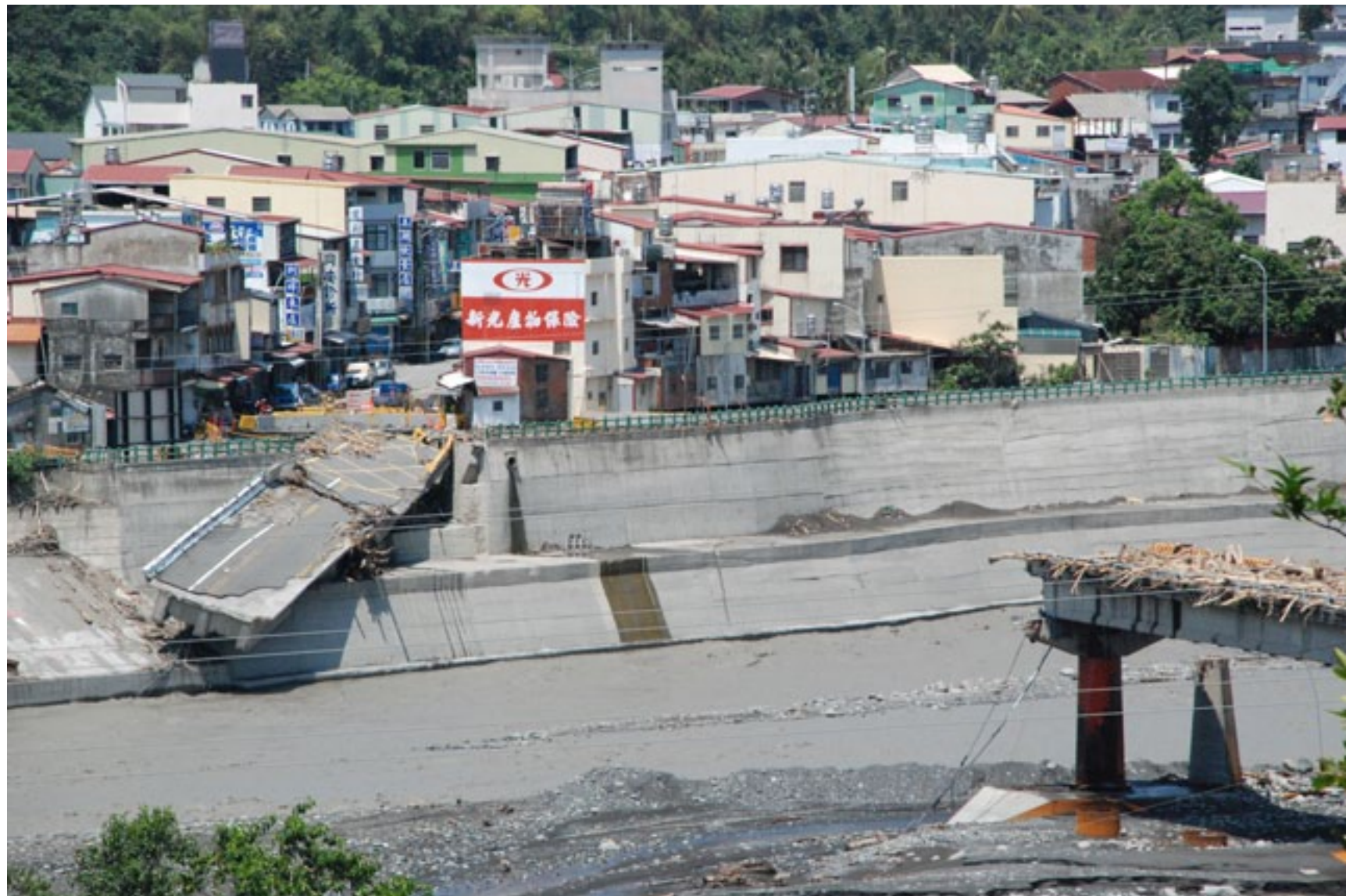
攝影 / 萬孝儀 地點 / 高雄縣六龜鄉 2009.08.19 《莫拉克颱風災況》被土石大水沖斷的六龜大橋。
